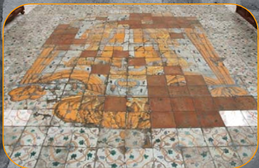
Pavimento in piastrelle smaltate (Chiesa di Santa Filomena, Ugento, LE)
